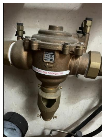
為使政府食水供應系統不受污染，折衷式消防栓/喉轆系統須安裝符合標準的防止回流裝置
