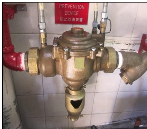
為使政府食水供應系統不受污染，擁有人須安裝符合標準的防止回流裝置
