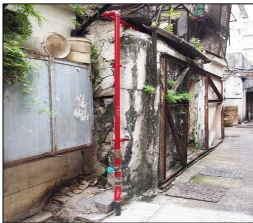
由街喉直接供水的折衷式喉轆系統
