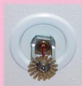
花灑系統 Sprinkler System
