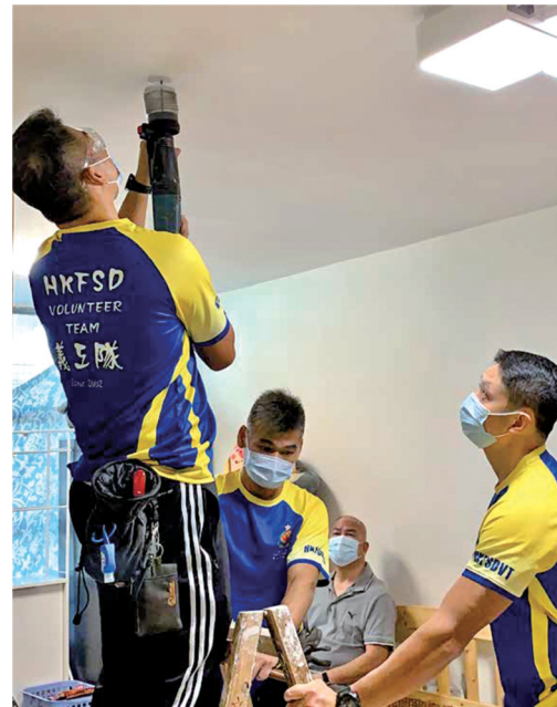
義工隊協助市民安裝獨立火警偵測器。
