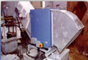
機械通風系統的自動中斷操作裝置
